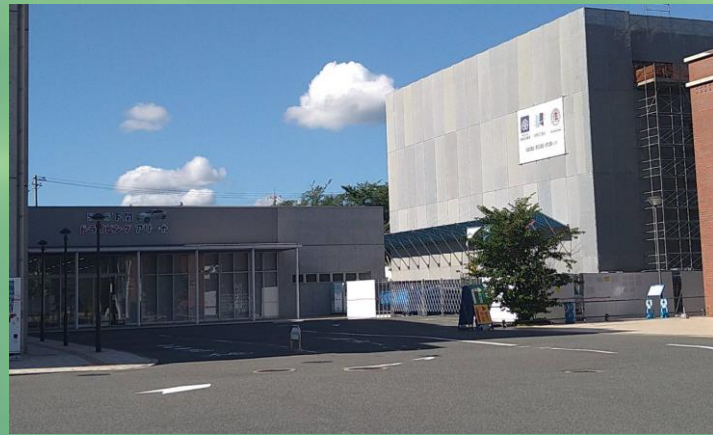
建設中のデータサイエンス学部(仮称)棟
